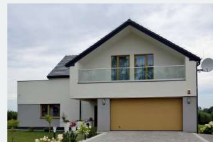
📌 Dwuwarstwowy mur przykryto silikonowym tynkiem w odcieniu kremowym i szarym.
