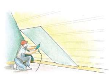
7. Przymocowanie płyt g-k.
