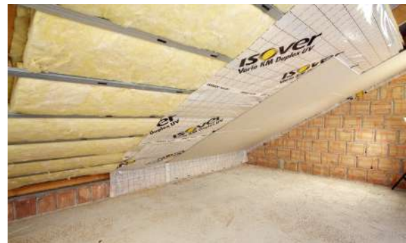
🔦 Folia paroizolacyjna chroni wełnę mineralną przed wnikaniem pary wodnej, wytwarzanej w użytkowanych pomieszczeniach. ISOVER
