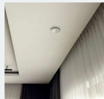
📍 Kanały ułożono m.in. na stropie nad parterem, przez otwory w podwieszanym suficie wyprowadzono odcinki rur z anemostatami.
