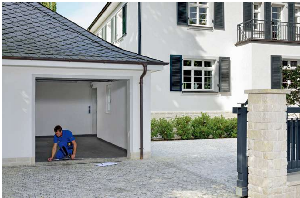
🔑 Bramy segmentowe obsadza się w wykończonym wnętrzu i na gotowej posadzce. Bez niej nie da się zaprogramować położenia końców bramy i po zrobieniu podłogi będzie potrzebna wizyta serwisanta. HÖRMANN
