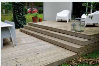
i Legary wykonano z kantówki sosnowej, nawierzchnię z modrzewia syberyjskiego.
