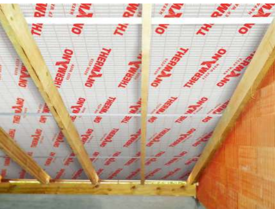
🔦 Płyty izolacyjne PIR na skośnym dachu układa się na krokwiach, nie między nimi. BALEX METAL
