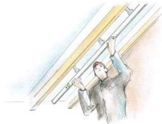
2. Montaż uchwyty do profili.
