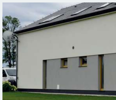
📍 Okrągły wlot, wykonany w „technicznej” wschodniej ścianie, to wyrzutnia powietrza.
