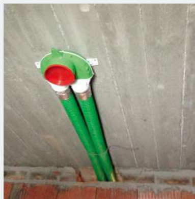
● Na czas budowy otwarte końcówki układu właściciel zaślepił plastikowymi denkami.
