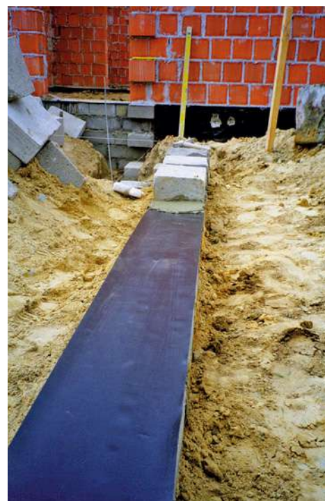
Kluczowym elementem zabezpieczenia fundamentów jest przeciwilgociowa izolacja pozioma, która oddziela ścianę nadziemia od mającej kontakt z gruntem ściany fundamentowej. GRILTEX POLSKA
