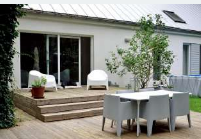
i Dwupoziomowy podest oparto na punktowym fundamencie z betonu.
