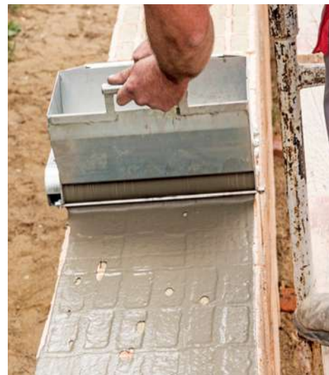
🔗 Dzięki zastosowaniu cienkich zapraw murarskich mur jest jednorodny, co korzystnie wpływa na ciepłochronność ścian. RÖBEN
