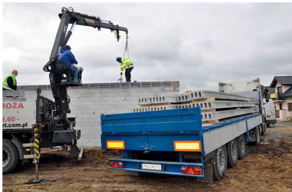
Montaż stropu prefabrykowanego trwa krótko, bo gotowe elementy potrzebne do budowy dostarczane są prosto z fabryki. STROPY.PL
