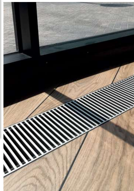
Grzejniki kanałowe umożliwiają przekazanie ciepła dokładnie tam, gdzie jest ono najbardziej potrzebne – bezpośrednio przy dużych przeszkleniach. VERANO
