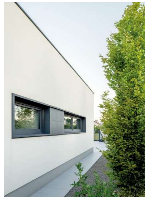
📍 Wnęki okienne również wykończono blachą. PROJ. MEEKO ARCHITEKCI / FOT. MACIEJ JEŹYK
