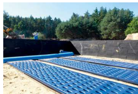
● Bezprzeponowy wymiennik ciepła umieszczony w obrysie fundamentów domu. PRO-VENT
