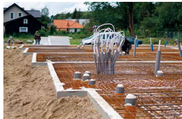
Płyta może być jednocześnie elementem grzewczym – z systemem kanałów, przez który płynie ciepłe powietrze. LEGALETT
