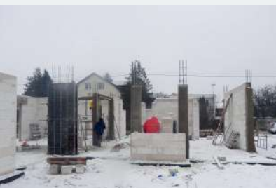
Wznoszenie części nośnej muru z bloczków silikatowych. Zbrojenie i wylewanie z żelbetu – słupów, nadproży, podciągów itp.
