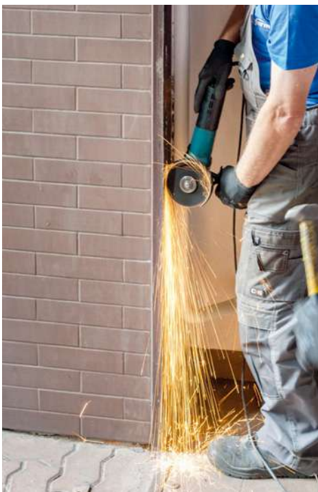
🔑 Usuwanie niepotrzebnych elementów starej stalowej ościeżnicy. NOVOFERM
