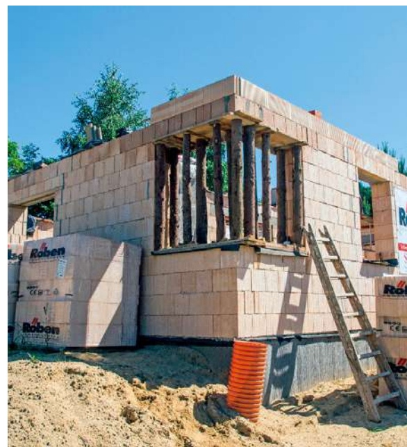
🔗 Mankamentem technologii jednowarstwowej jest ryzyko powstawania mostków termicznych. Aby temu zapobiec, warto stosować ocieplone prefabrykaty oferowane przez producentów materiałów ściennych. WIENERBERGER, RÖBEN
