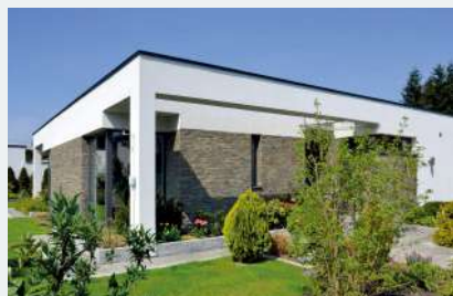
Na dwuwarstwowym murze (z silikatu i styropianu) ułożono tynk silikonowy i okładzinę z łupka.
