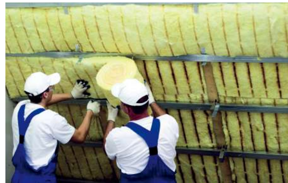
🔦 Wełnę mineralną układa się w dwóch warstwach o łącznej grubości 25–30 cm. URSA
