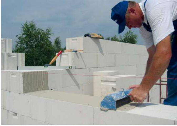
📌 Precyzyjne wymiary bloczków z betonu komórkowego umożliwiają murowanie na cienkie spoiny. SOLBET
