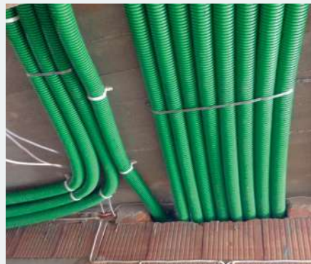
Zdjęcia z montażu. Rury wentylacyjne biegną pod żelbetowym stropodachem i przez otwory wykonane w ścianach działowych, są przymocowane taśmami.
