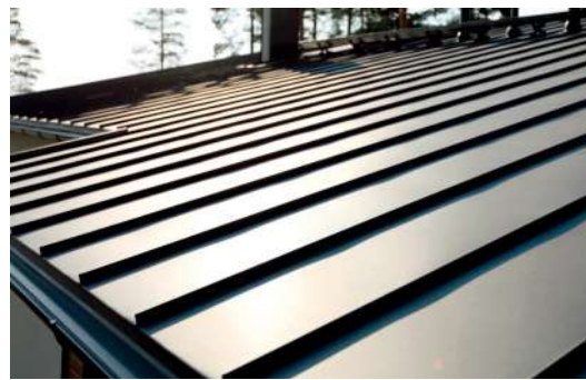
W zasadzie im mniejszy spadek połaci, tym szczelniejsze pokrycie trzeba na niej układać. RUUKKI
