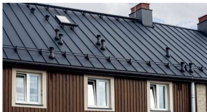
📍 Płaska blacha panelowa – połączenie przypomina rzemieślniczy rąbek stojący. BLACHPROFIL 2
