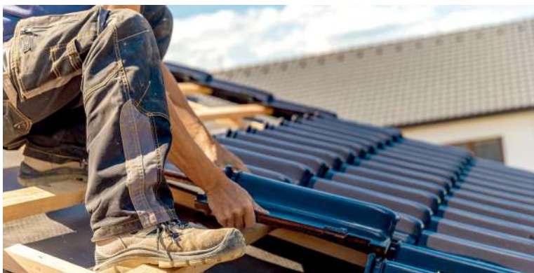
📍 Dachówka układana na ruszcie z łąt i kontrłąt. CREATON POLSKA
