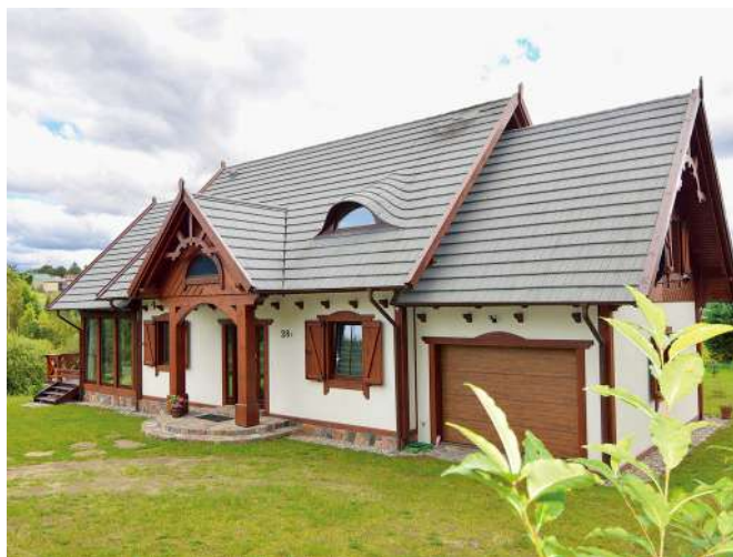
Blachodachówka z posypką dobrze tłumi odgłosy deszczu. AHI ROOFING
