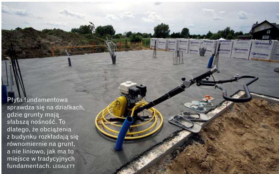
Płyta może być jednocześnie elementem grzewczym – z systemem kanałów, przez który płynie ciepłe powietrze. LEGALETT
